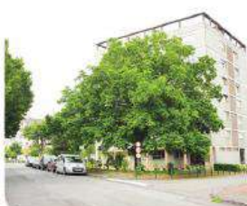
DES ARBRES REMARQUABLES
