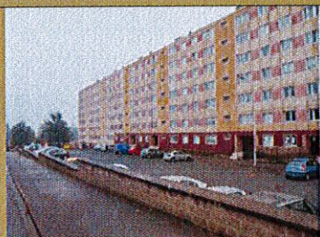
Résidence Jeanne III (82 logements)
