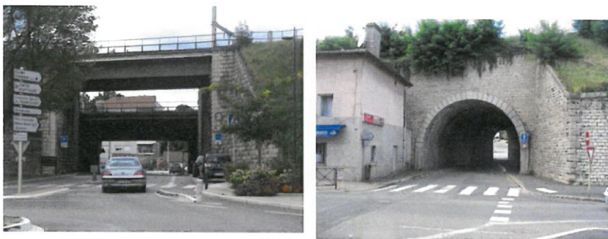
Les entrées du quartier (St Clément et rue des Trappistines)
